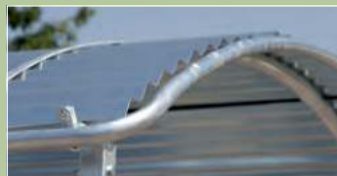
Borde de protección en todo el perímetro del tejado
